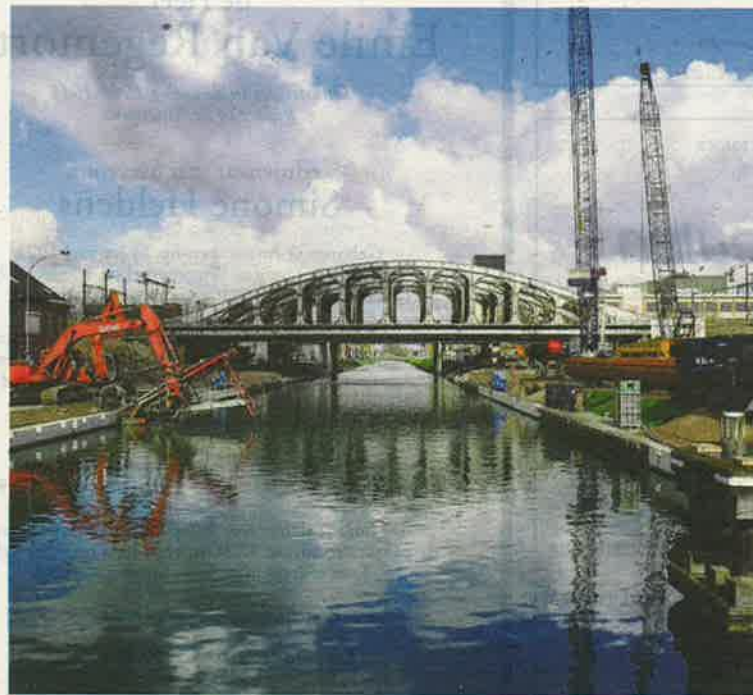
Aan de zijde van de Hanswijkvaart worden de eerste palen al in de kanaaloever gedreven. FOTO PATRICK HATTORI
