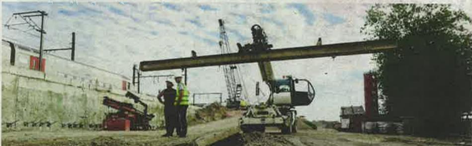
De diepwanden voor de tunnel onder de Leuvense Vaart zijn klaar. Het wegdek daarvan zal bijna 7 meter diep onder de bodem van het kanaal zitten. FOTO PATRICK HATTORI
