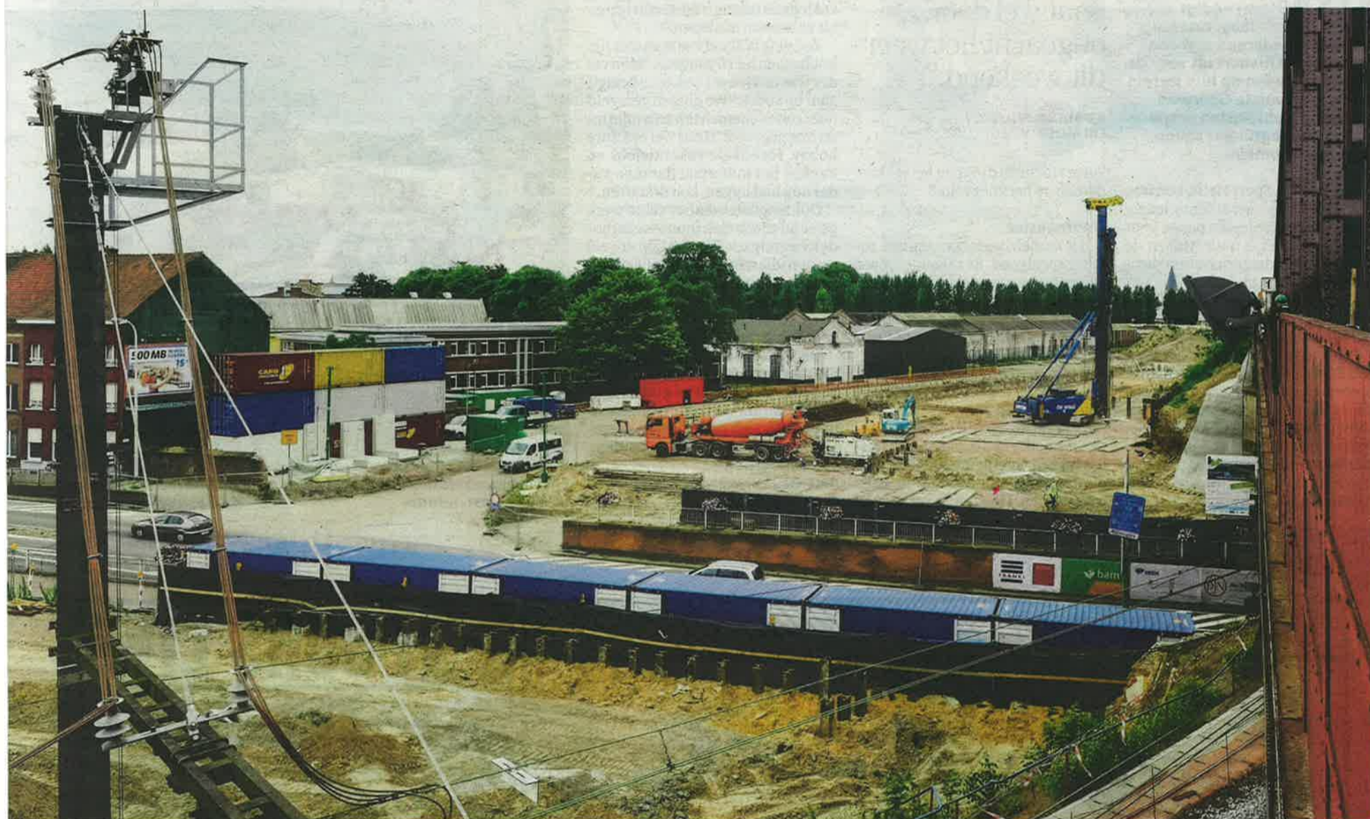
zone voor de nieuwe spoorbypass is 3,2 kilometer lang. Van op de Vierendeelbrug aan de Leuvensesteenweg wordt de impact van de werkzaamheden goed duidelijk. FOTO PATRICK HATTORI
