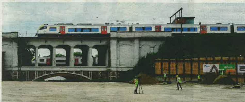
Voor de bouw van een autotunnel onder de sporen en een spoorwegbrug over de Dijle is de rivier tijdelijk gedempt. FOTO PATRICK HATTORI
