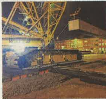
De balken worden geplaatst met een enorme kraan. FOTO GVA
